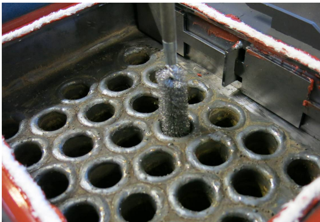
Рис. 37 - Чистка трубчатого теплообменника
