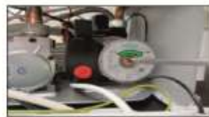
5. Затяните обратно центральный винт (2,5 Нм) и закройте лицевую панель котла
